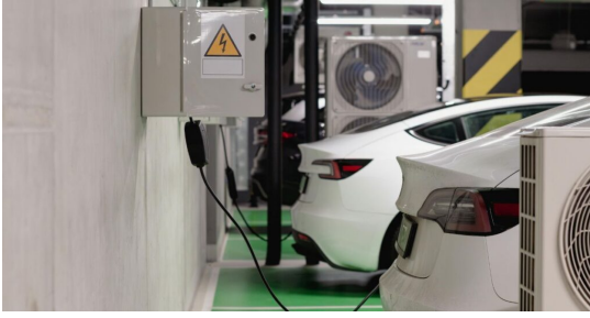
© Smartme Building Technologies Kft. Elektromosautó-töltőállomások parkolóházban
